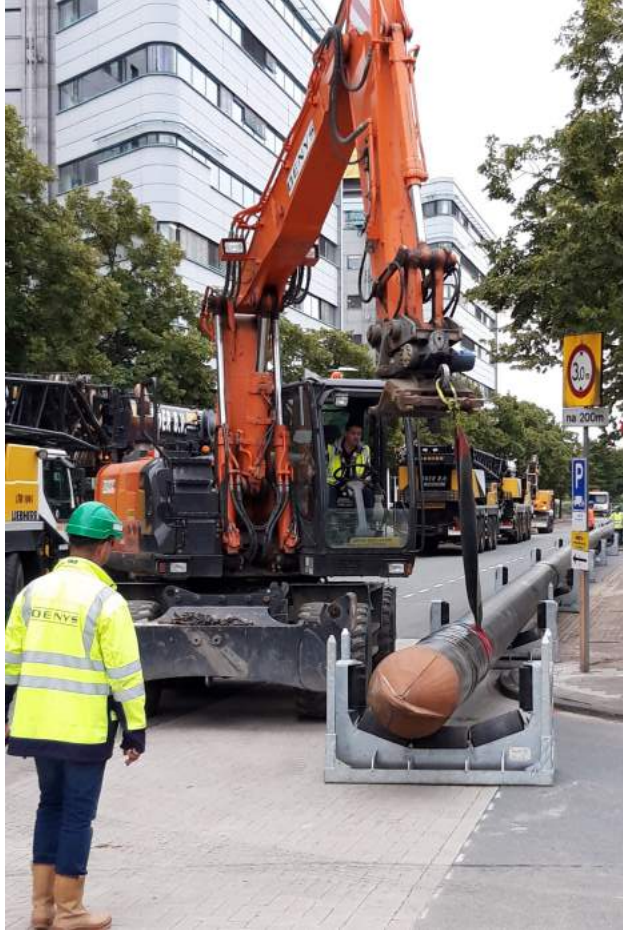
HDD BORINGEN STAAL-PUR-PE DN400/500
